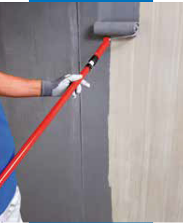
Нанесение Eco Prim Grip Plus на бетон
