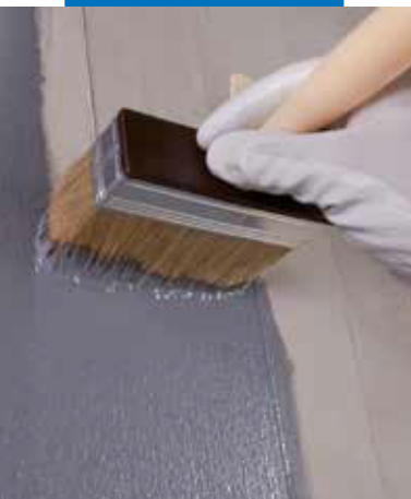
Нанесение Eco Prim Grip Plus на бетон
